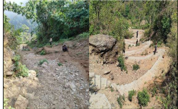
बेसारडाँडा गल्ली निर्माण- बबक काम हुनु पुर्व काम सम्पन्न पछि
